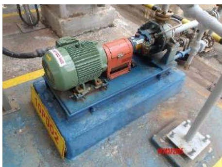
ภาพที่ 2.2-2 ปั๊มที่มีระบบป้องกันการรั่วไหล 2 ชั้น (Double Mechanical Seal)
