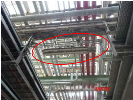
ภาพที่ 2.2-31 ระบบส่องสว่างภายในพื้นที่โครงการ Normal & Emergency Lighting และ Safety Lighting
