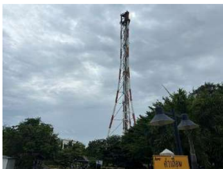
ภาพที่ 2.2-3 หอเผาที่ระดับเหนือพื้นดิน (Elevated Flare)
