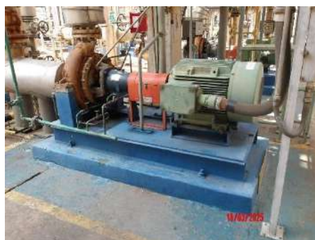
ภาพที่ 2.2-2 ปั๊มที่มีระบบป้องกันการรั่วไหล 2 ชั้น (Double Mechanical Seal)
